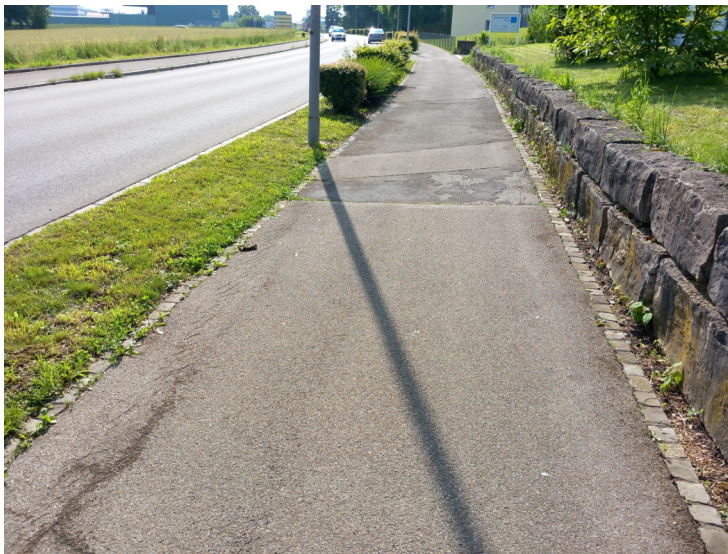
Abbildung 14 Beispielfoto Randabschluss Gehweg
