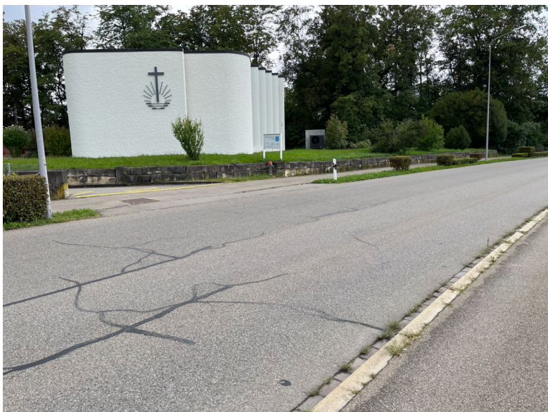
Abbildung 11 Vergossene Risse im Fahrbahnbelag
