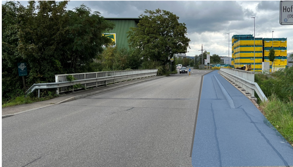
Verbreiteter Rad-/Gehweg über die Brücke Richtung Hofstetten.
