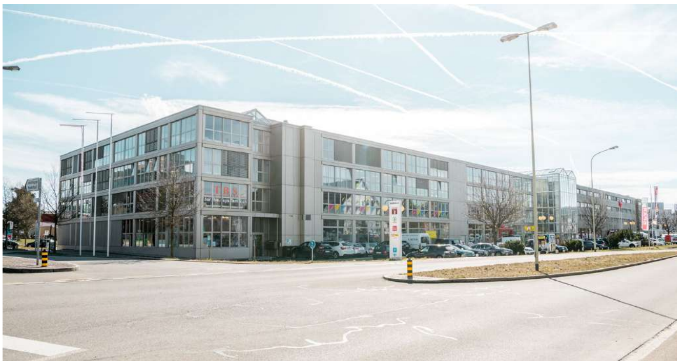
Abb. 10 Mandachgebäude, neuerer Gebäude- teil von 2007 © HIAG
