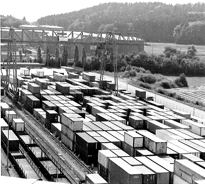
Blick auf das Containerdepot in Niederhasli
