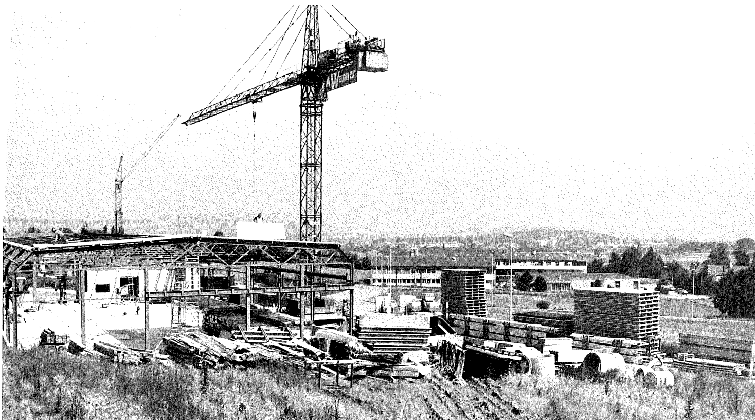
In der Industriezone von Oberhasli entsteht ein neues Büro- und Fabrikgebäude
