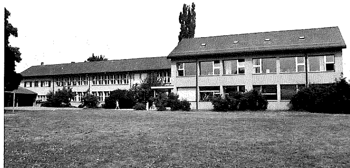
Zentralschulhaus von 1950 in Mettmenhasli mit Anbau von 1975
