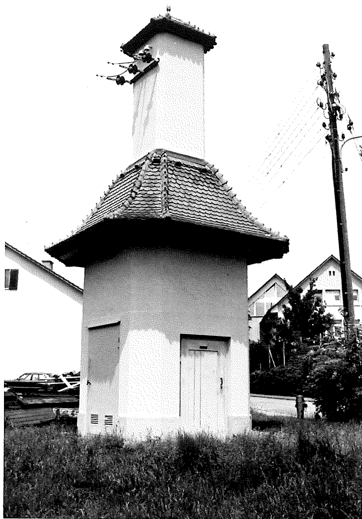
Alte Transformatorstation gegenüber dem Schulhaus Rossacker
