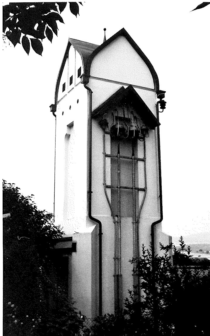
Die erste Transformatorenstation hinter dem Restaurant Trube
