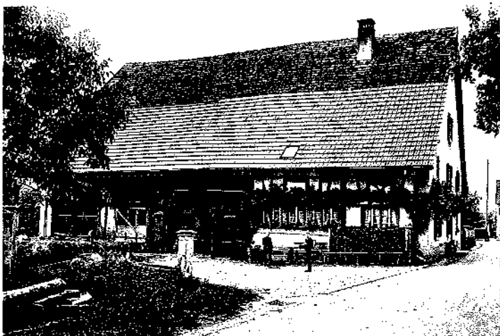
Bauernhaus von Ernst Derrer-Marthaler, Sandrainstrasse 4 in Oberhasli (Aufnahme 1964)
