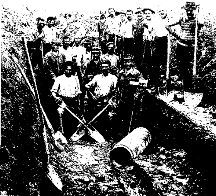
Draineure beim Ausheben des Hauptsammelkanals 1918
