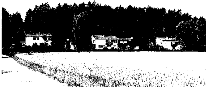
Einfamilienhäuser am Hürdliweg in Nassenwil
