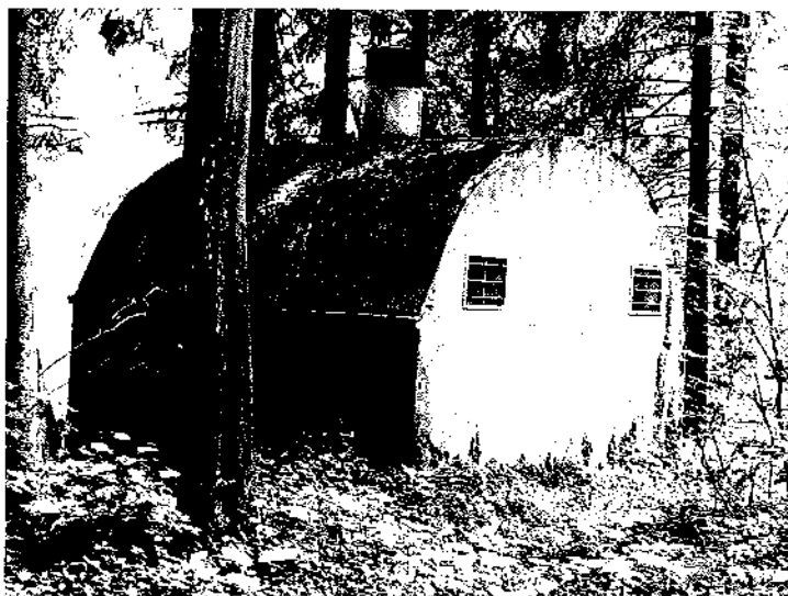
Das älteste Reservoir von Oberhasli im Gross-Ibig
