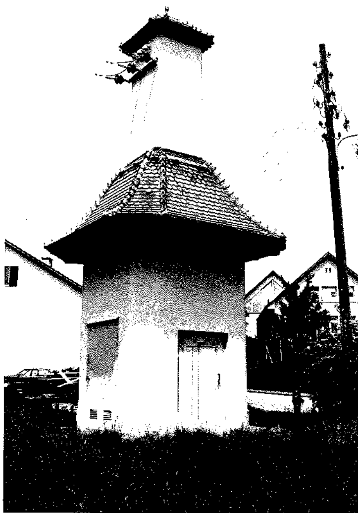
Alte Transformatorstation gegenüber dem Schulhaus Rossacker
