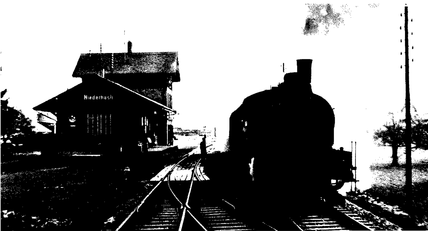
Station Niederhasli um 1959 kurz vor der Elektrifizierung
