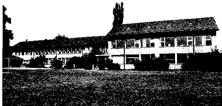
Zentralschulhaus von 1950 in Mettmenhasli mit Anbau von 1975
