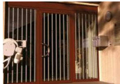
Flächig wirkende Markierungen bieten den besten Schutz. Fotoquelle: www.vogelwarte.ch
